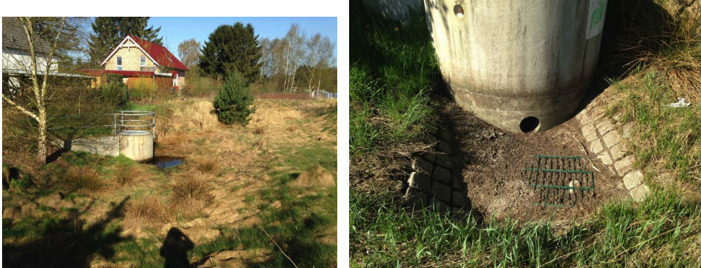
Abb. 5: Gewässer 1 (links: April, rechts: Mai)
